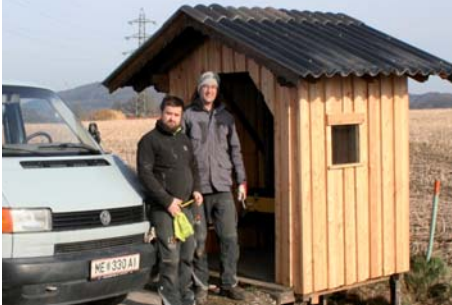
Nach den erfolgten Sanierungsarbeiten bei Buswartehäusern sind diese freundlicher und einsichtiger geworden.
