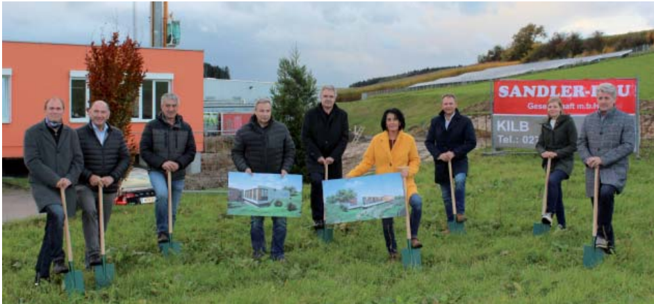
Gemeinsam mit den Vertretern der Baufirma, den Planern, dem Vertreter der Marktgemeinde und ausführenden Firmen nahmen Herta und Johann Janker den Spatenstich für die Büroerweiterung vor.
