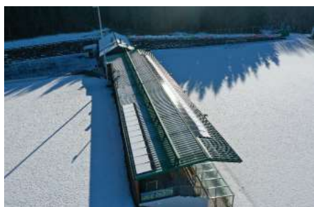
Umsetzung am Dach der Tribüne
