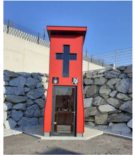
Die Kapelle beim Feuerwehrhaus Kilb
