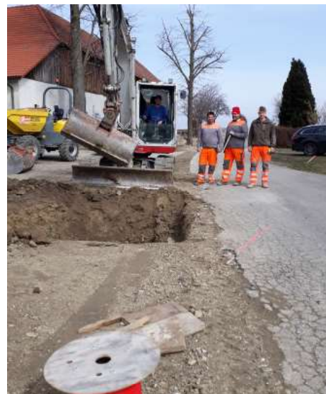
Bau einer Transportleitung (am Rametzberg) zum Hochbehälter II
